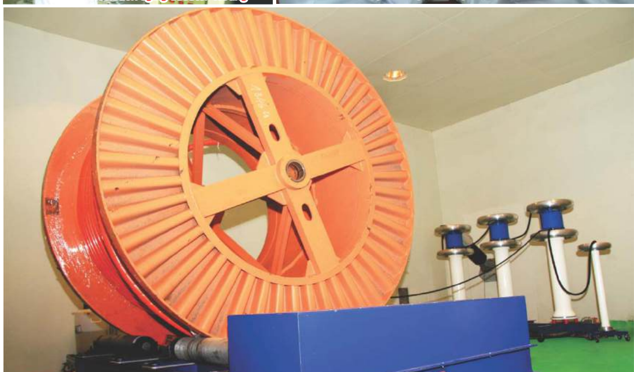
Thử nghiệm cao áp cáp trung thế / High voltage of medium voltage cable testing
